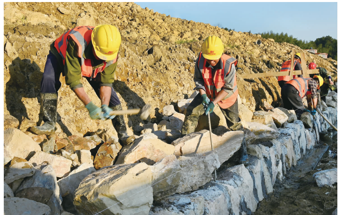
近年来，防汛防洪、救灾应急等基础设施项目备受关注。图为湖南邵阳冬修水利施工现场。
