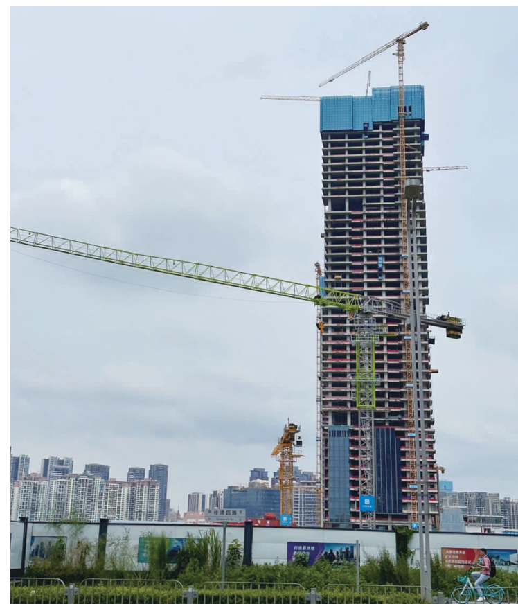
深圳一项目正在抓紧建设。
