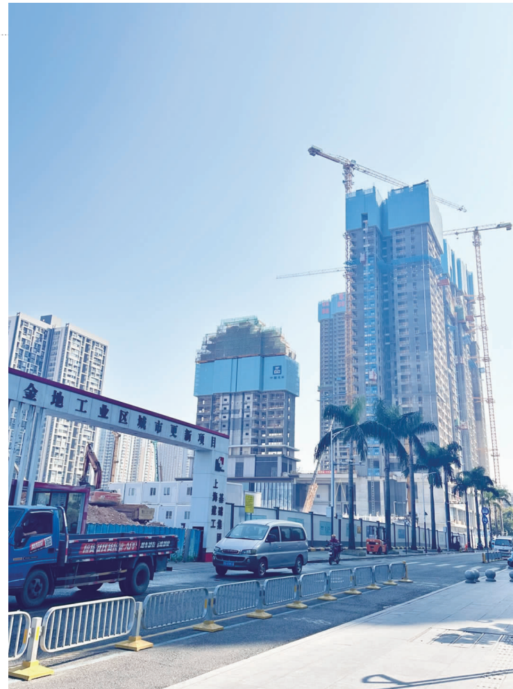
深圳金地环湾城项目施工现场。
