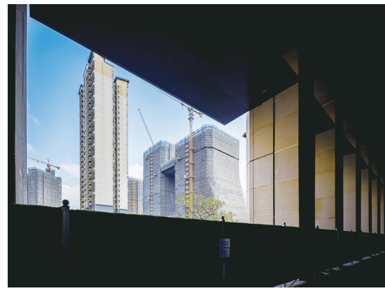
在“加快构建房地产发展新模式”导向引领下,房地产业加快向“新”而行正成为行业共识。图为广东省广州市某在建房地产项目。 视觉中国/图
