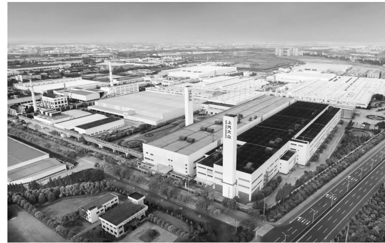
2022年,上汽大众安亭基地实现了100%接入水电,成为上海地区首家实现100%使用可再生电力生产的汽车制造企业。
