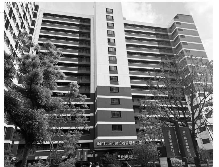
位于上海市闵行区华漕公寓社区的“新时代城市建设者管理者之家”。 本报资料室/图
