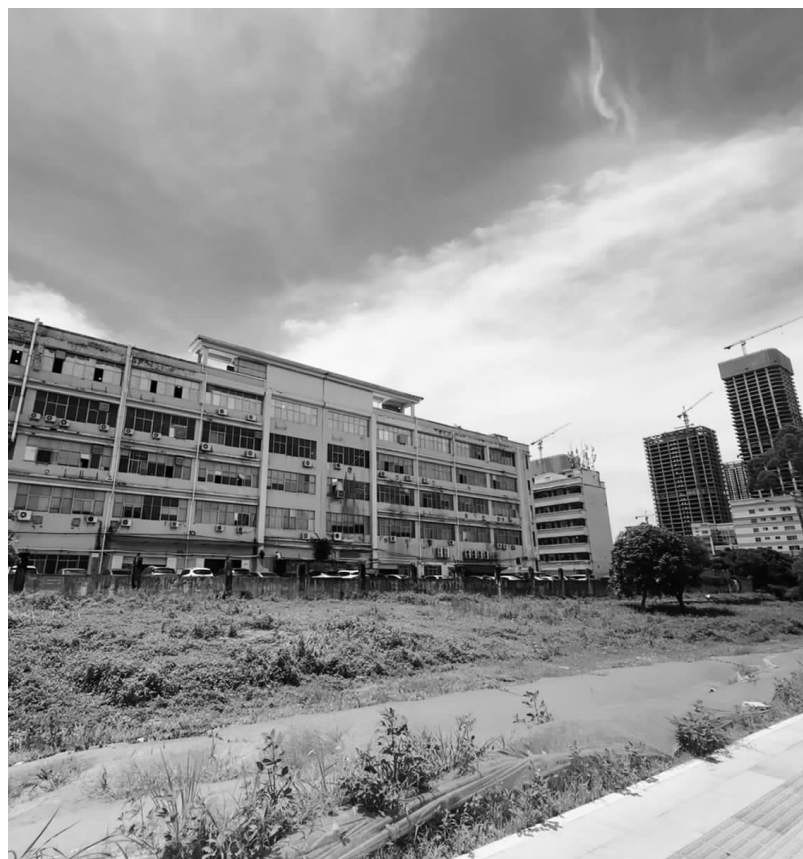
坪山大道中段其间伫立多个工业厂房，未有拆除施工迹象。
