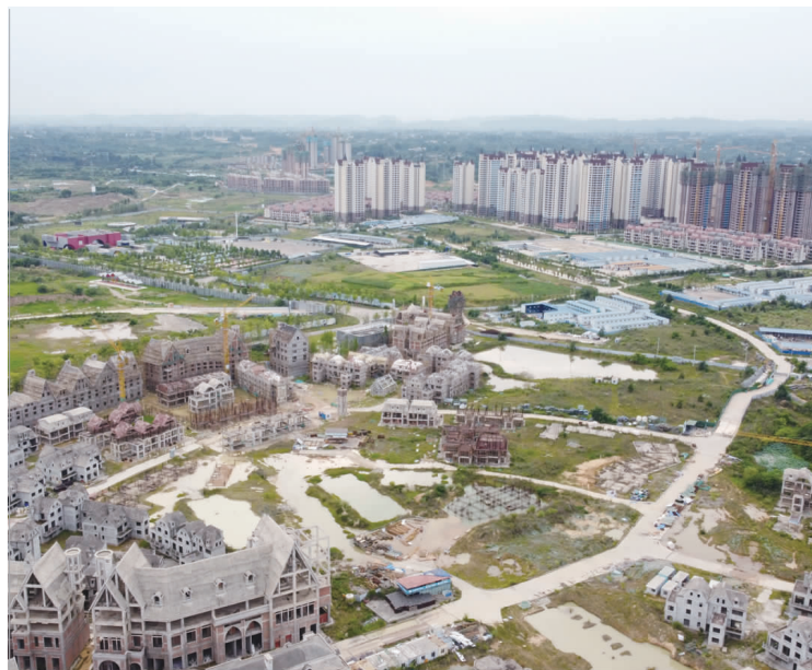
四川乐高乐园施工陷入停滞，但不远处的住宅项目已经陆续建成。 本报资料室/图
