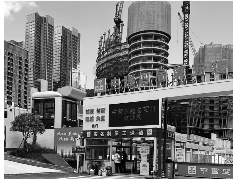
深湾玖序项目施工现场一片忙碌。
