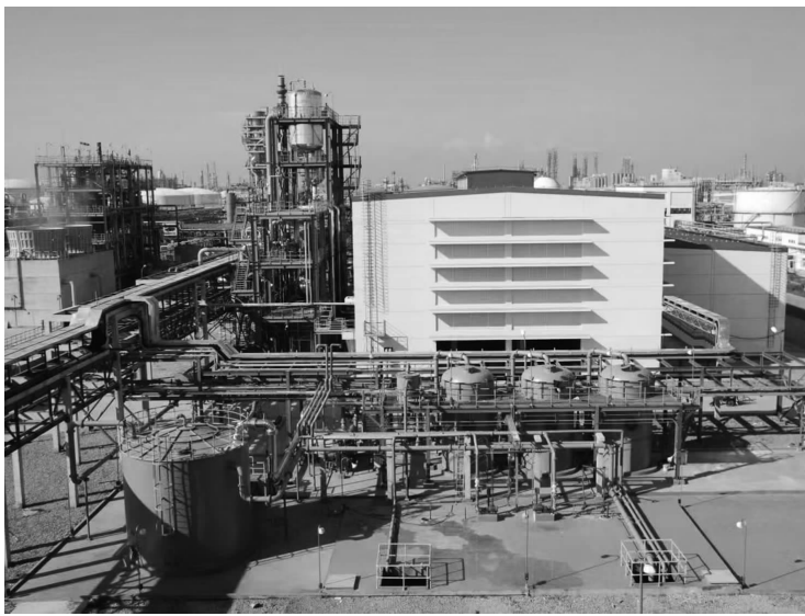
氯碱化工华胜分公司烧碱装置。
