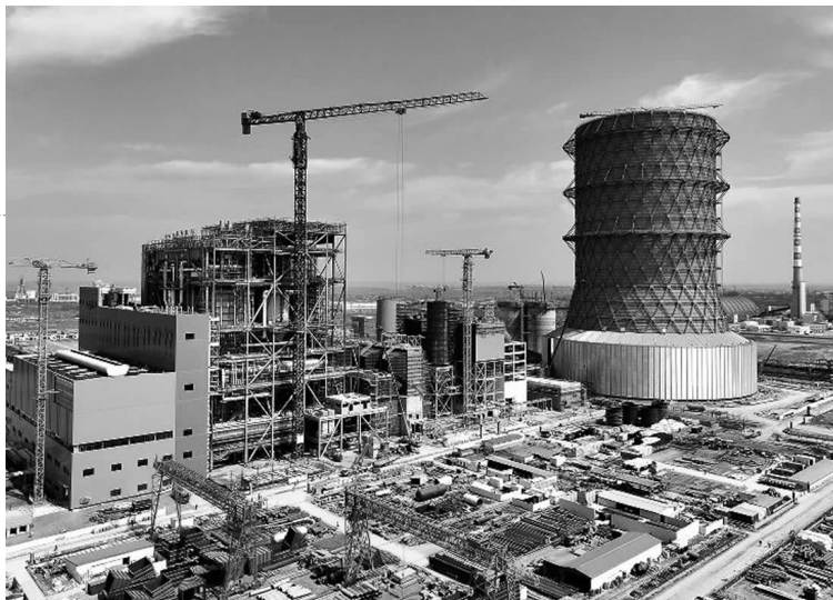
陕煤彬长矿业CFBC示范项目施工现场。
