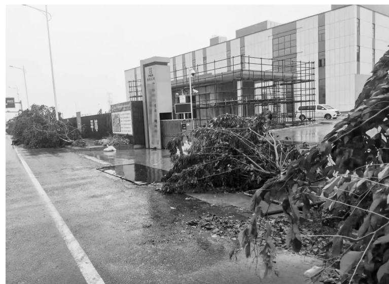
图为广东省雷州市某工程项目财物灾后受损现场。
