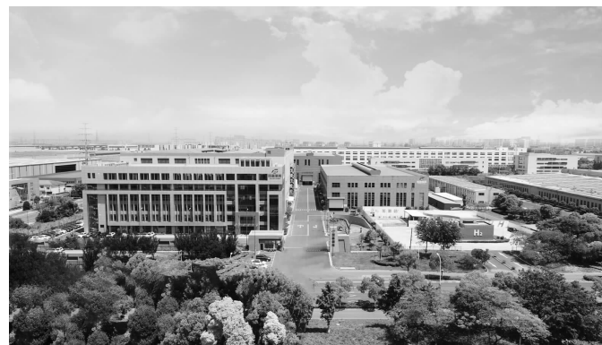
江苏国富氢能技术装备股份有限公司厂区。
