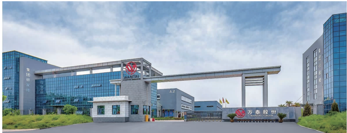
万泰股份厂区。
