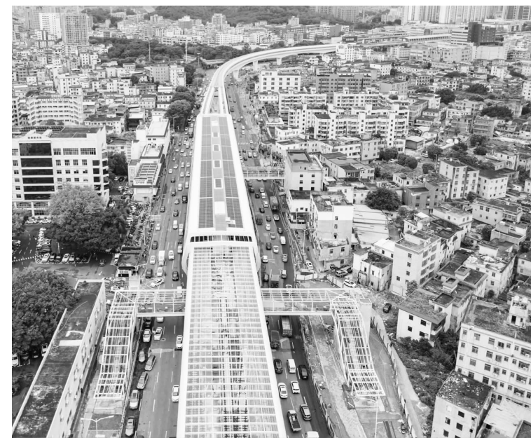
深圳地铁3号线四期梨园站(施工现貌)。
