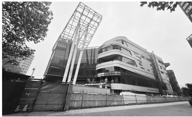
金牛大悦城项目主体已经建成，但未继续进行装修施工。 陈雪波/摄影
