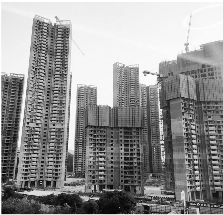
今年11月,东莞明确实施“购房可申请落户”政策,图为东莞一处在建楼盘。 陈婷/摄影
