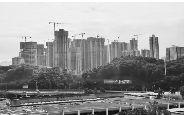
深圳龙岗区一处集中在建楼盘。
