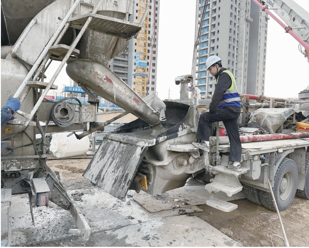
图为西部建设下属子公司在作业筏板浇筑任务。
