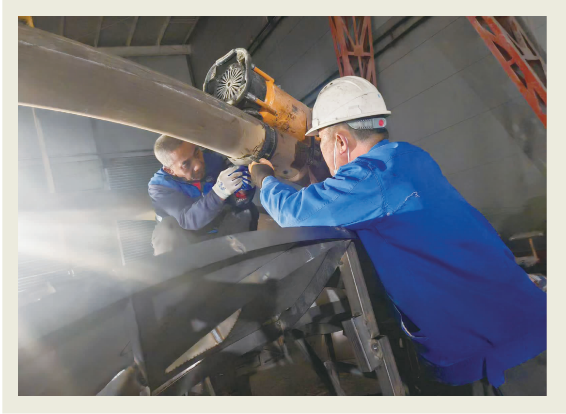
图为施工人员进行花瓣边缘支撑结构探伤实验。
