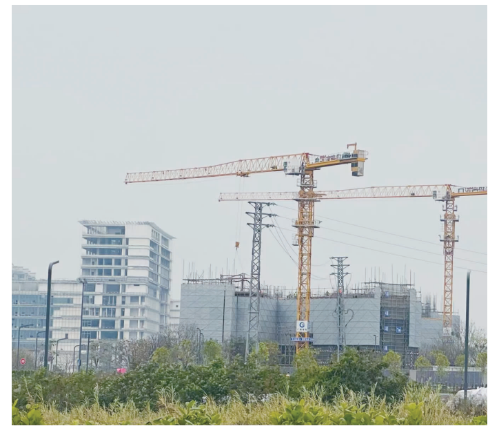
广州南沙区一处在建楼盘。
