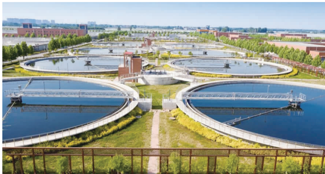
中原环保郑州新区污水处理项目。
