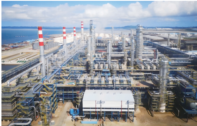
恒逸石化文莱一期项目。
