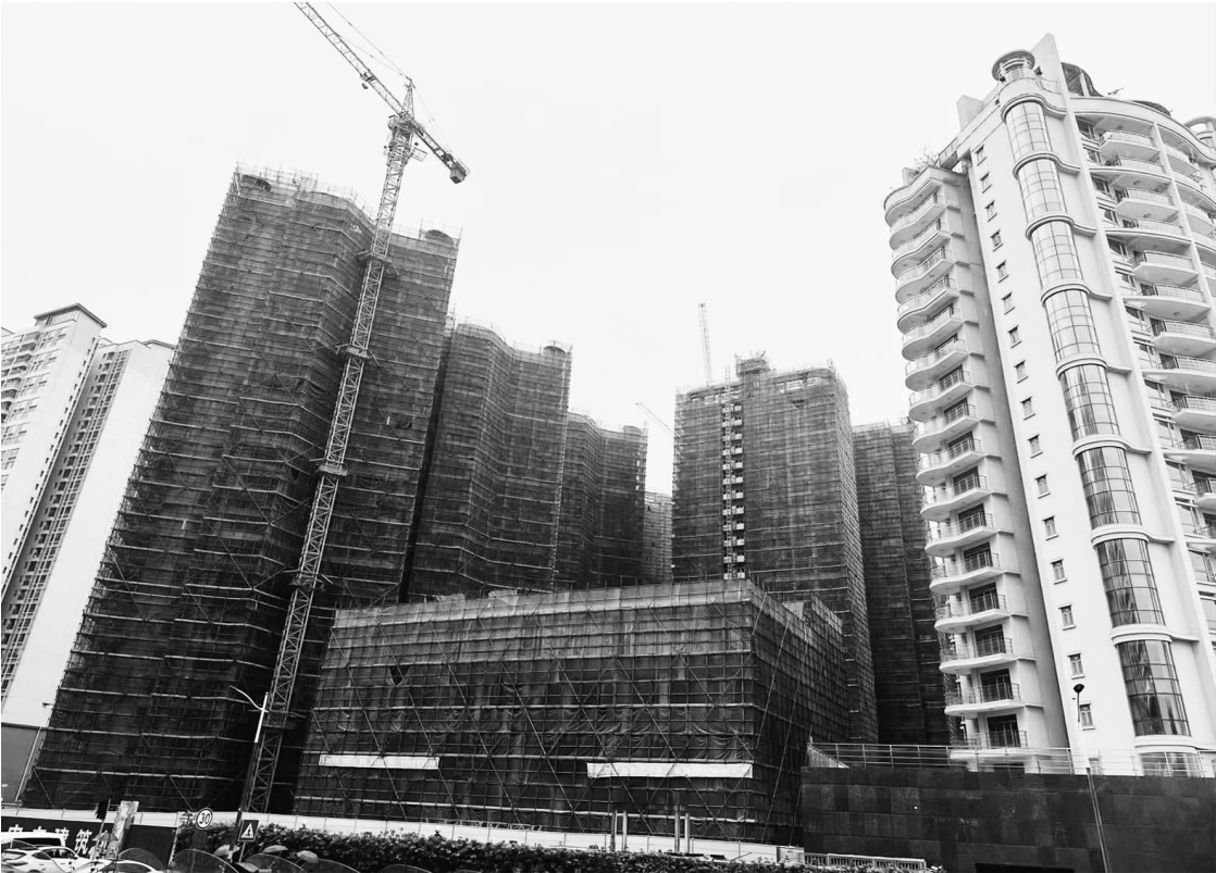
5月8日起,广州同步下调个人住房公积金贷款利率。图为广州天河区一处在建待竣工楼盘。
