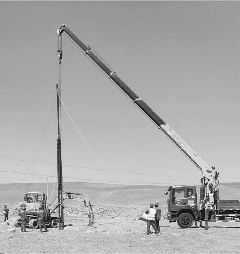
广汇能源旗下矿业公司白石湖露天煤矿7兆瓦工业环网建设现场。
