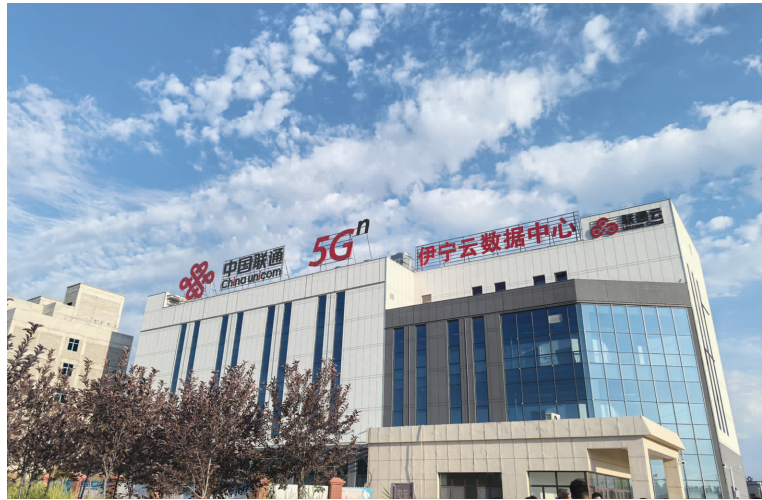
据不完全统计,截至2024年年底,三大运营商在算力基础设施建设上的投入累计约1000亿元。 秦泉/摄影
