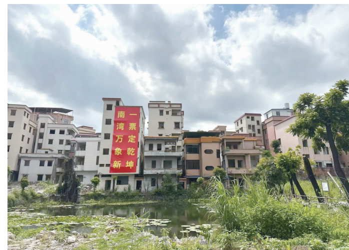
广州黄埔区南湾村旧改项目即将重新推进。
