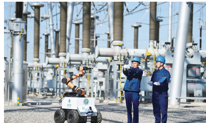
2025年11月25日，安徽省滁州市，南谯区500千伏同乐变电站，一台5G+量子智能巡检机器人和运维人员正在对站内主设备进行巡检作业。
