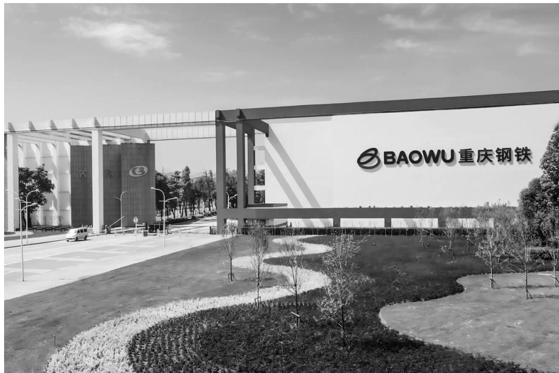
图为重庆钢铁厂区。
