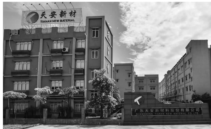
天安新材公司总部。
