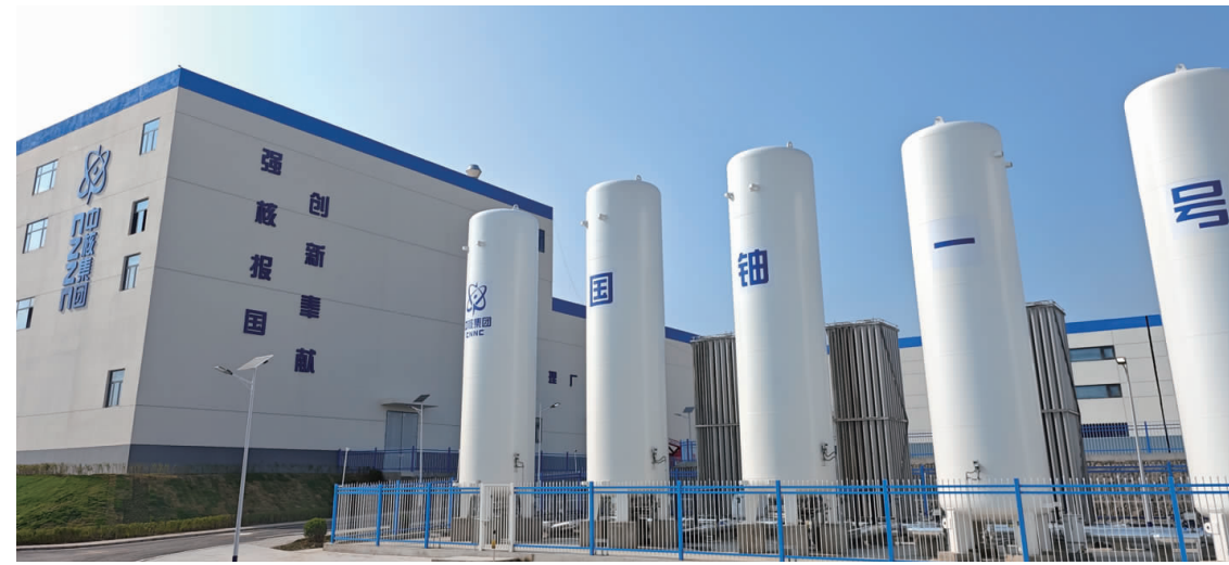
中核集团“国铀一号”示范工程现场。
