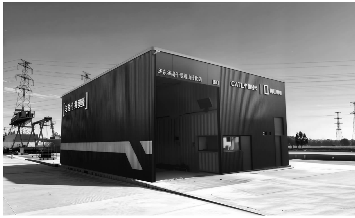
图为宁德时代旗下麒麟换电站。
