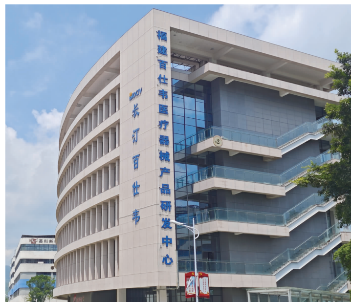
图为位于长汀医疗器械产业园内的福建百仕韦医疗器械产品研发中心。方超/摄影
