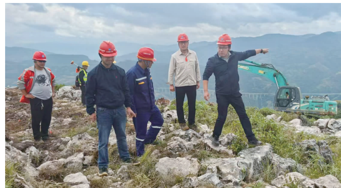
图为三峡集团职工在富民的光伏电站修建现场。
