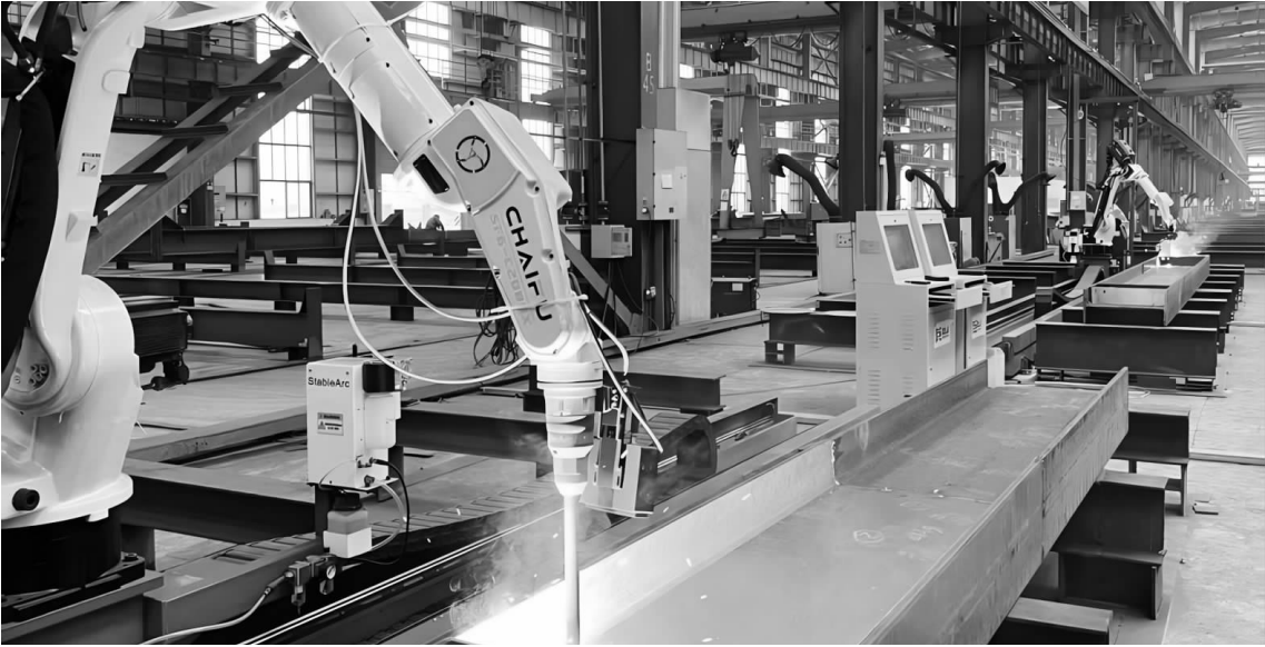
图为富煌钢构数字化车间里的智能焊接机器人。
