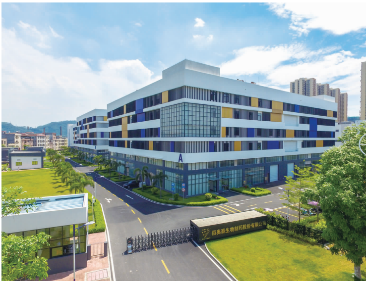
图为百奥泰公司大楼。
