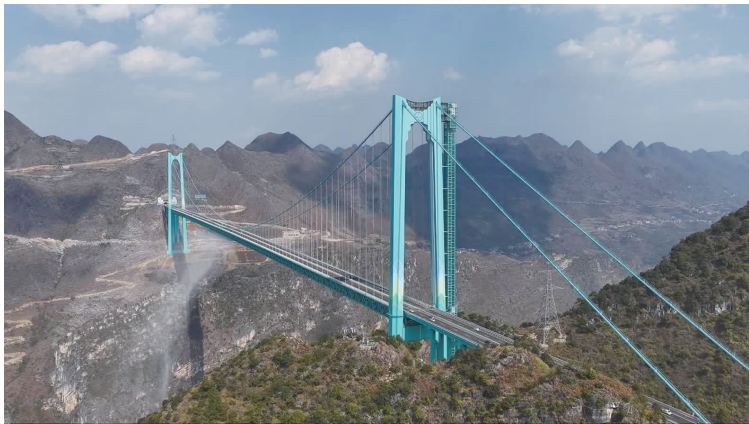
花江峡谷大桥横跨两岸，将约2个小时绕行缩短至约2分钟。
