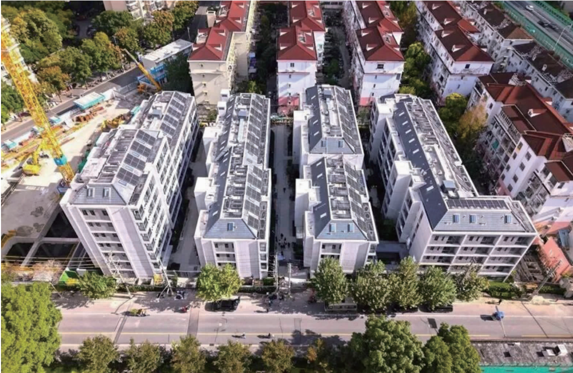
“原拆原建”后的上海市市民新村居民区上楼有电梯、下楼有花园。
