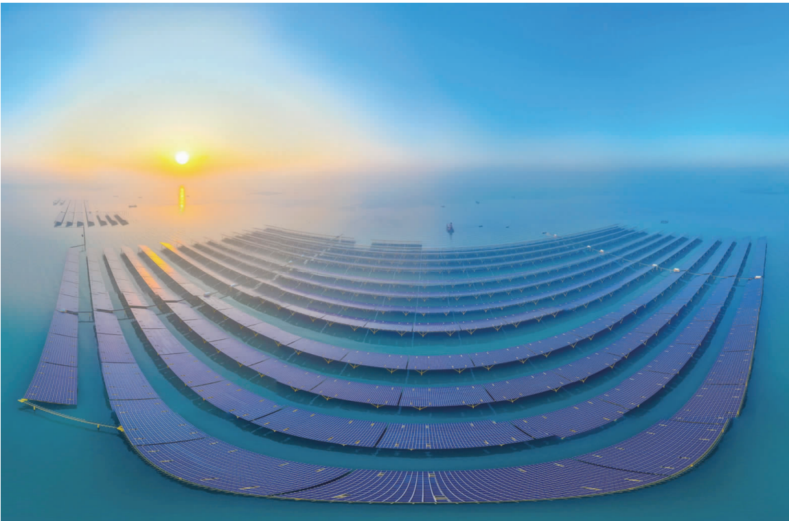
图为山东青岛即墨区鳌山湾海域海上桩基固定式光伏发电项目。
