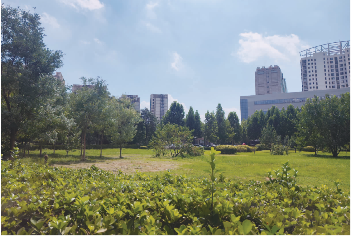
图为国家干细胞工程产品产业化基地三期建设项目现场。
