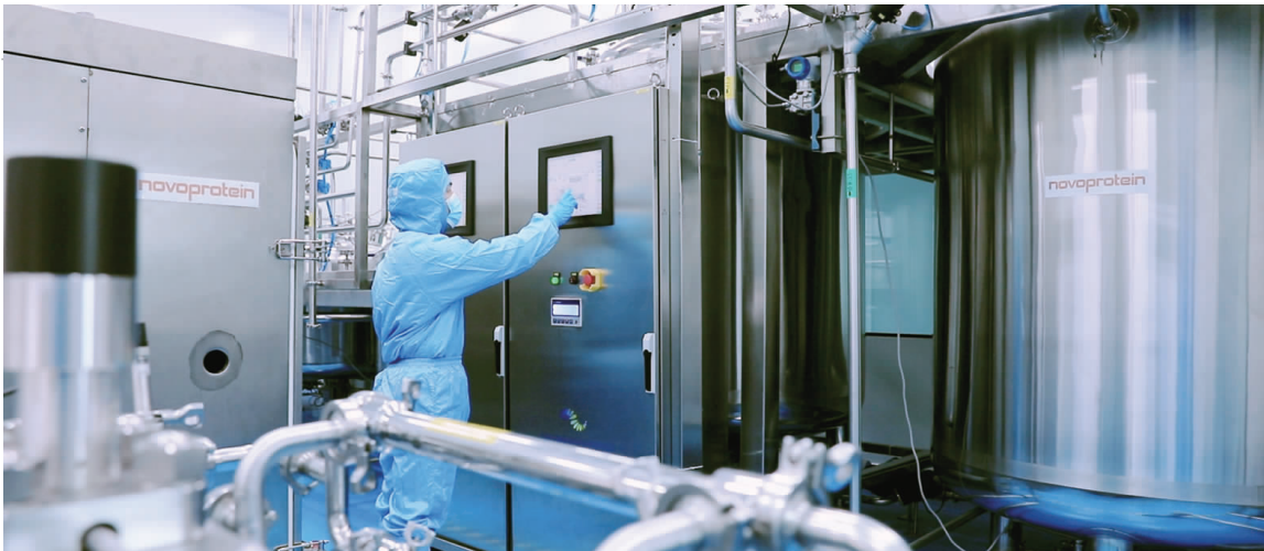
图为近岸蛋白厂房内部。
