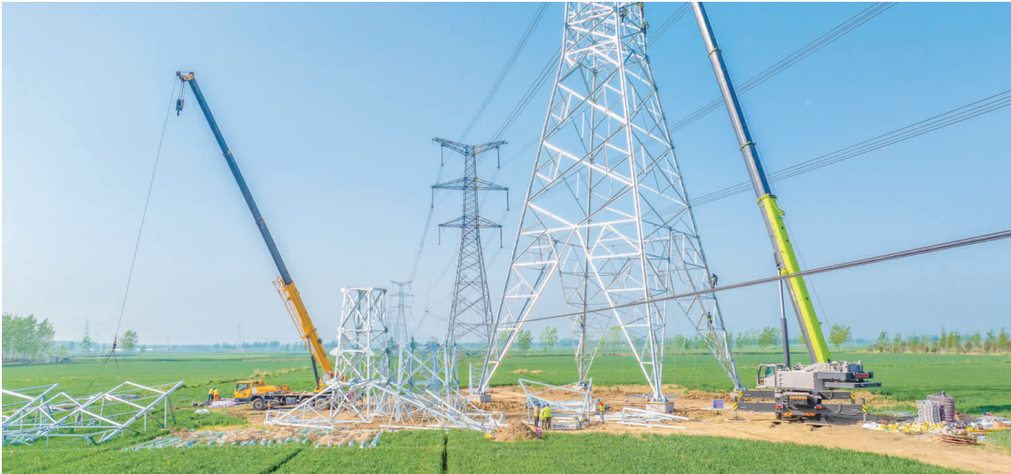
在江苏省宿迁市泗洪县车门乡境内,500千伏高压线路迁改现场,施工人员正在组合、吊装新电塔,保障当地电力升级。
